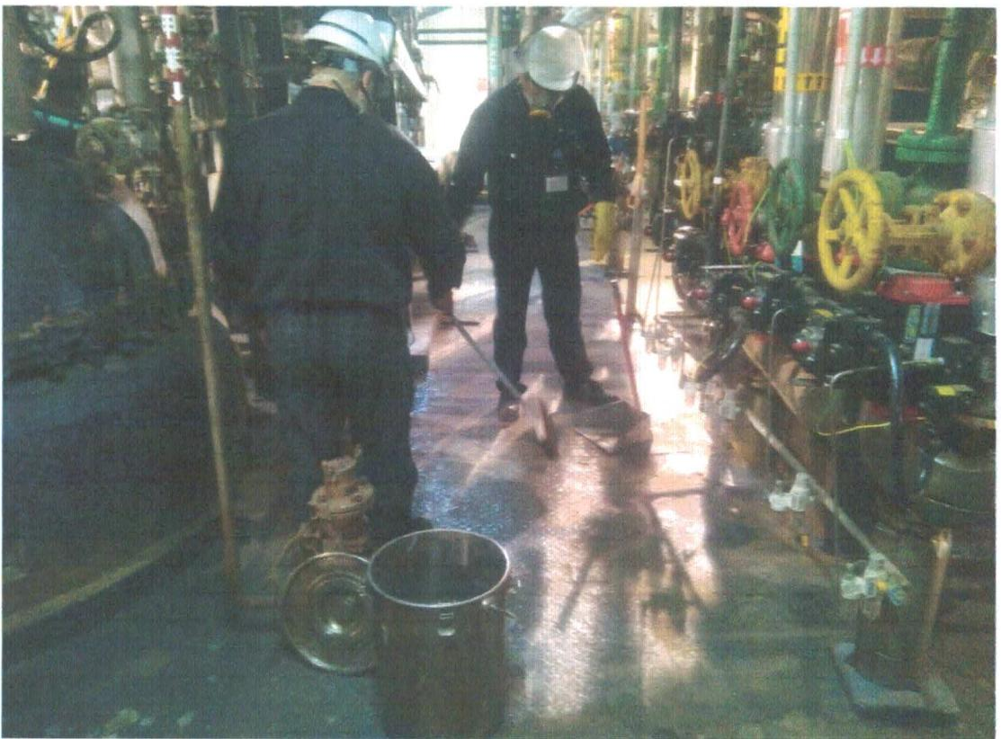
7、打开缓冲罐真空泵，将泄漏的溶剂抽至缓冲罐暂存
